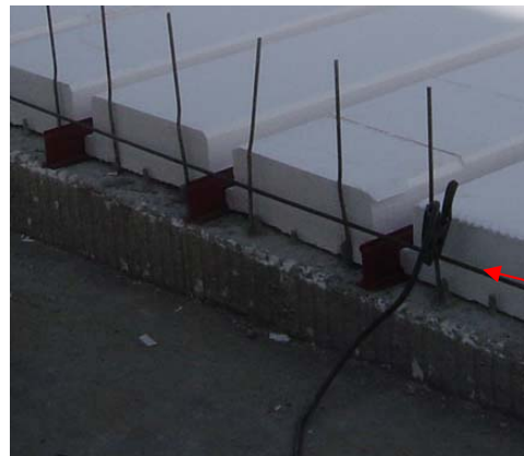
Imagen #9. Detalle acero perpendicular al perfil
